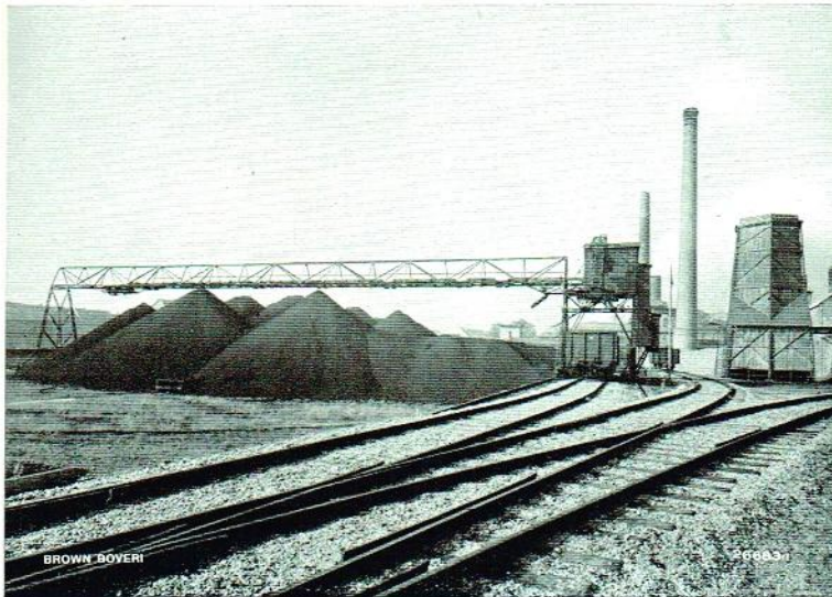
Abb. 52. Kohlenentladeanlage einer Zuckerfabrik.
